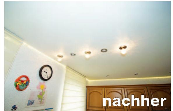
Nachher: abwaschbare, weiße Spanndecke mit energiesparender Seiten LED-Beleuchtung und modernen Deckenleuchten
