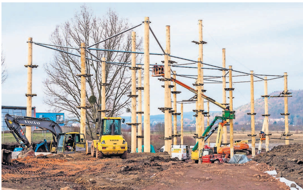
Le nouveau parc d'escalade est en construction à Merzig.
