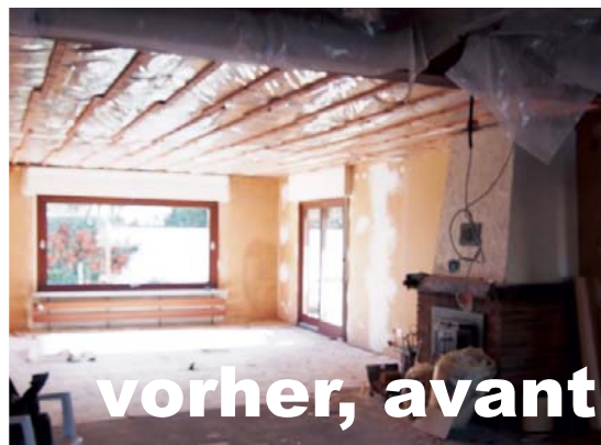
Vorher: Wohnzimmer mit entfernter "alter" Holzdecke
